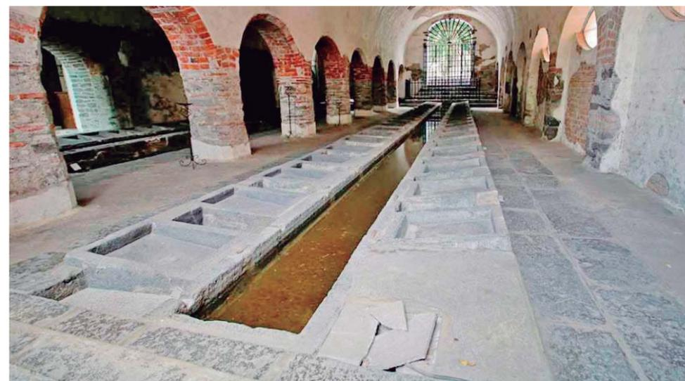
del daño sufrido por los visitantes, le ha faltado mantenimiento adecuado durante los últimos años, pues se aprecian grietas, pérdidas de aplanado, deterioro en los elementos de cantera, pisos, así como afectaciones en el sistema de drenaje antiguo.
