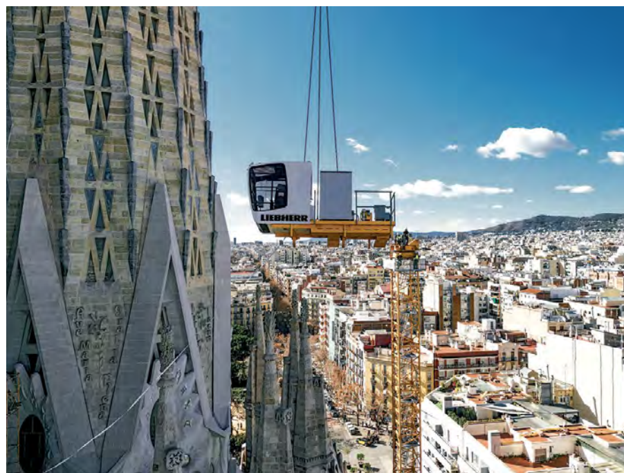
LAS GRÚAS FUERON ELEGIDAS en parte por su diseño plegable, lo que minimiza el impacto en los edificios circundantes.
